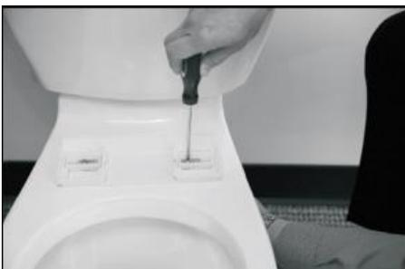
7. Setzen Sie von oben, durch die Scheiben und die Passstücke, eine Schraube in die Montageöffnung der Schüssel ein.
