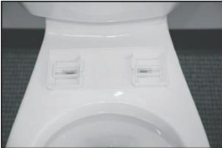
4. Legen Sie die Passstücke auf die Montagevorrichtung und platzieren Sie die Scheiben in den Passstücken.
