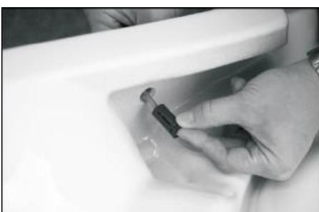
8. Führen Sie das Befestigungsrohr von unten in die Montageöffnung der Schüssel ein, bis Sie die Schraube in das Befestigungsrohr einführen und die Mutter erreichen können. Halten Sie das
