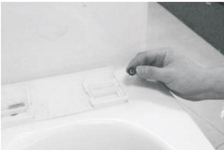
5. Setzen Sie die Muttern in die Kappen. Benutzen Sie die großen Kappen, wenn Sie die großen Befestigungsrohre verwenden, und die kleinen Kappen, wenn Sie die kleinen Befestigungsrohre verwenden.
