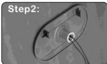
2ème étape. Insérer le barillet à travers la plaque de base (retirer la pellicule protectrice de l'adhésif double face 3 M ) et, depuis l'intérieur, insérer ces deux pièces dans le trou pratiqué dans la porte puis tourner pour les fixer avec l'optique du judas.
