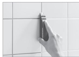
3. De slijpsteen in de droge voeg aanbrengen. Vervolgens **MET LICHTE DRUK** naar voren en weer terug schuiven. Het vuil wordt daarbij losgemaakt.
