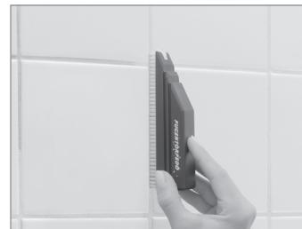
3. Den Schleifsteg in die trockene Fuge ansetzen. Dann **MIT LEICHTEM DRUCK** vor- und zurückziehen. Der Schmutz wird dadurch gelockert. Alle zu reinigenden Fugen auf diese Weise vorbehandeln.
